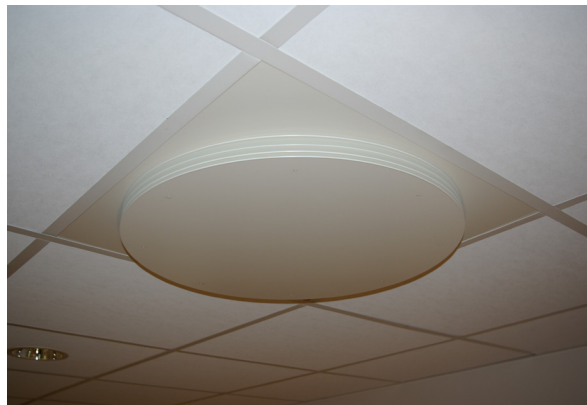
Det reaktiva tilluftsdonet MTD monterat i undertak.
