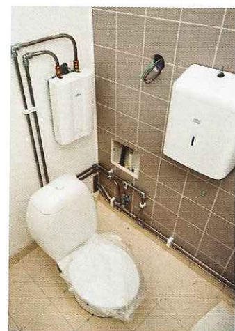
Lokala varmvattenberedare är ett sätt att minska energianvändningen.
